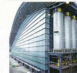
作為新落成的社區設施，T-Park「源·區」可「轉廢為能」，既可減少堆填區的壓力，又能夠產生都市可再生能源，減少其他發電燃料。
