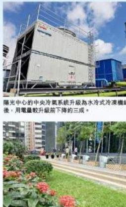
陽光中心的中央冷氣系統升級為水冷式冷凍機組後，用電量較升級前下降約三成。
