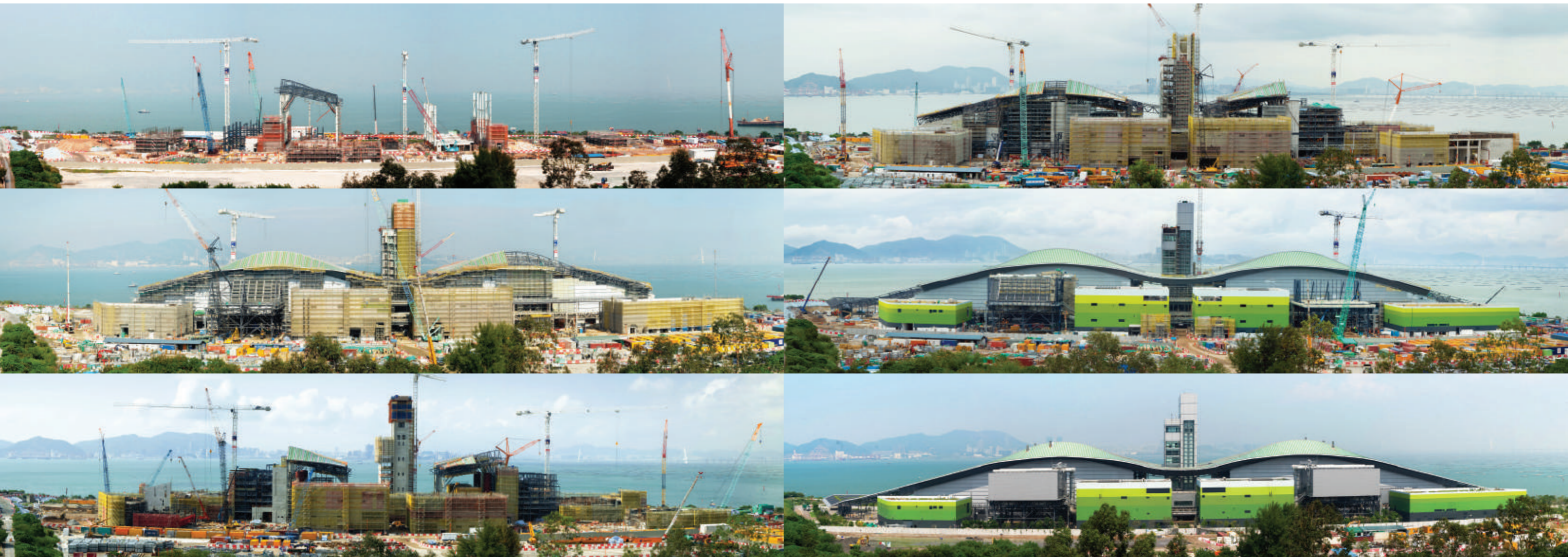
Construction work commenced in October 2010 and the site area is about 7 hectares. 建造工程於2010年10月展開，設施佔地面積約七公頃。
