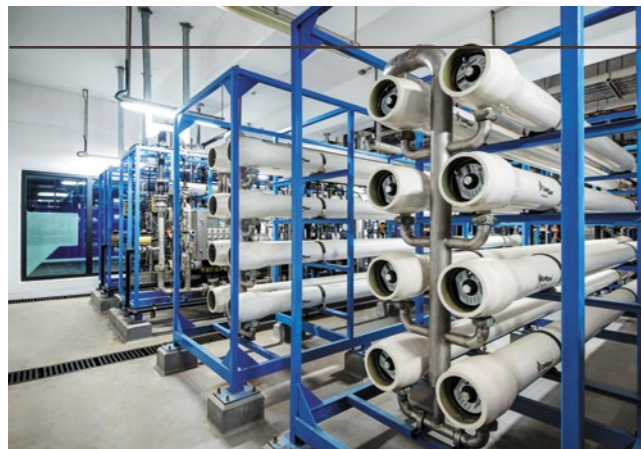
逆滲透 (Reverse osmosis) 過程中令海水脫鹽，提取出純淨的飲用水。逆滲透系統有24支導管，共128塊過濾膜。
