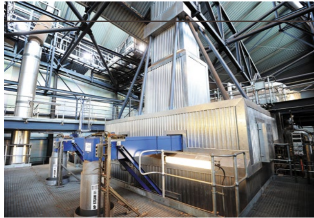
圖為污泥焚化爐的頂部，整個爐被多層的隔熱膜保護，減少損耗。
